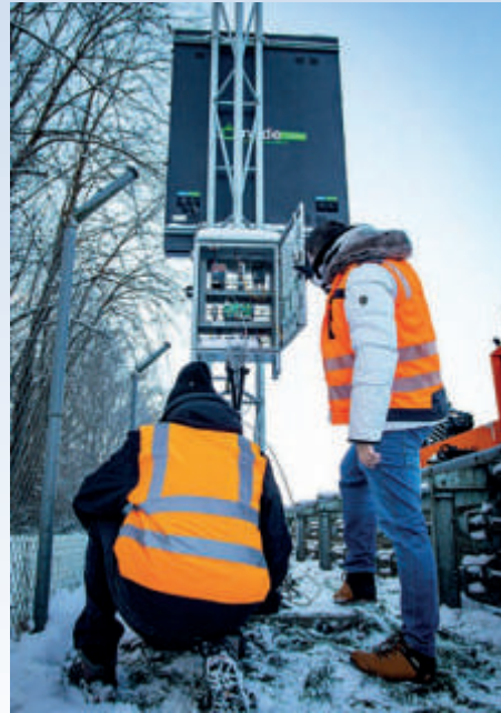
Installation der dynamischen Ansteuerung einer LED-Wechselverkehrszeichenanlage an der Teststrecke
