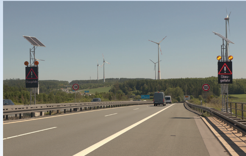
Stauwarnsystem auf der A 72 unmittelbar vor dem Autobahndreieck Hochfranken
